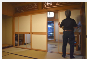
襖兼用簾戸の取り替えをしているところ
